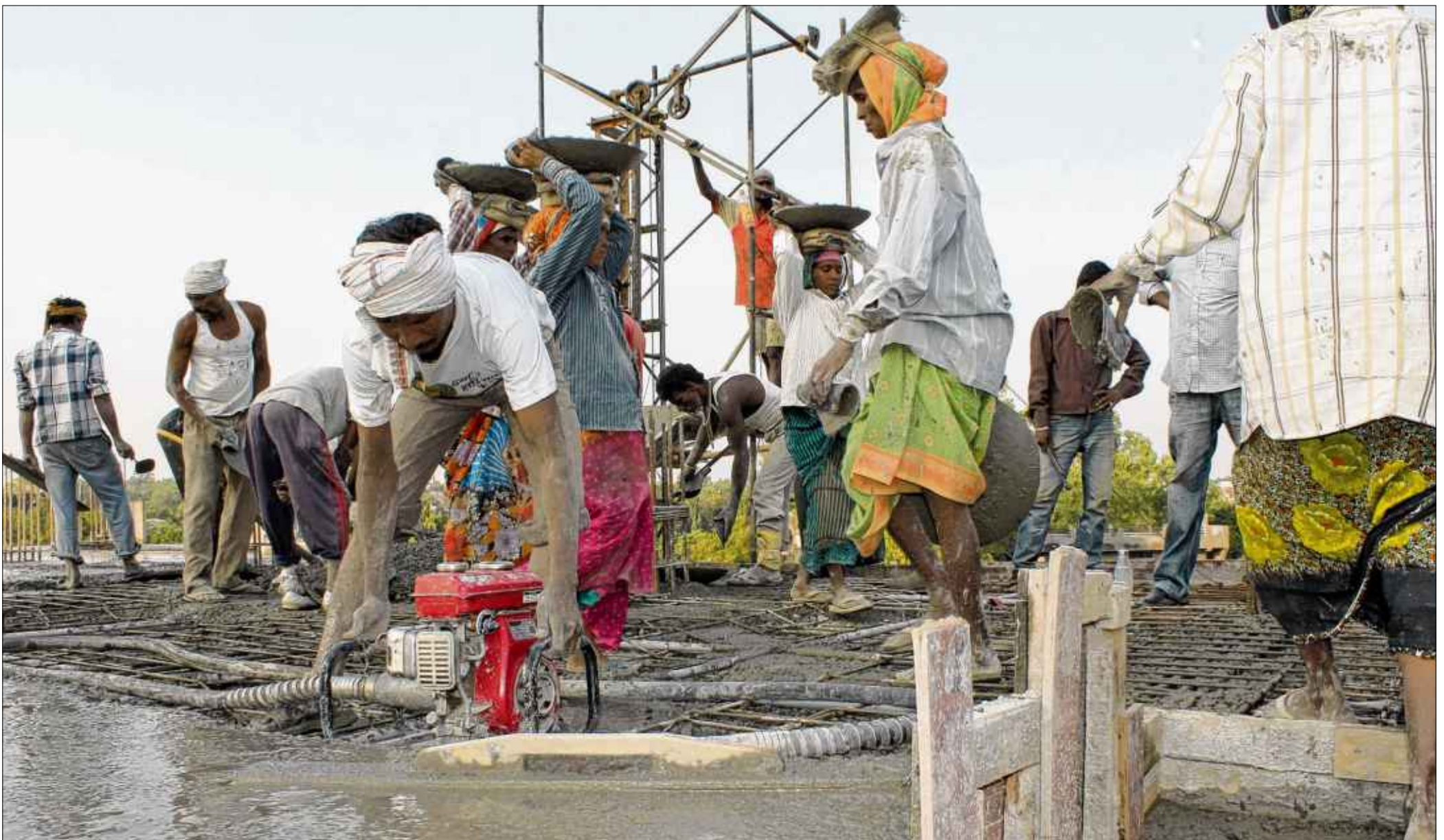
Das Schulwohnheim wird zwar in solider Bauweise aus Eisen, Beton und Backstein gebaut, aber aus Kostengründen werden oft billige Arbeitskräfte statt Maschinen eingesetzt.
